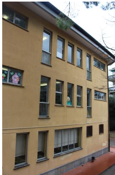
Figura 1.1 - Vista della facciata esposta a Nord-Est
