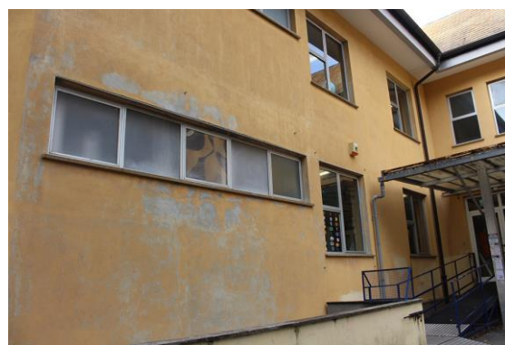
Figura 8.7- Particolare delle murature
