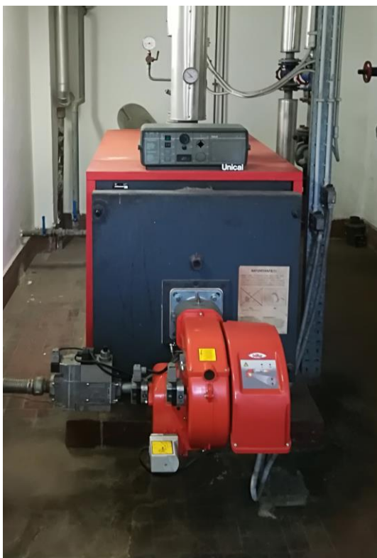
Figura 4.8 - Particolare della caldaia Unical P420
