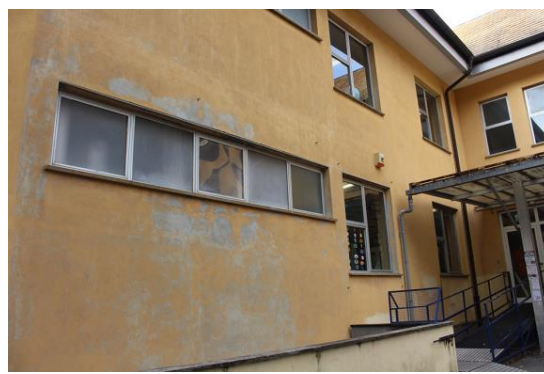
Figura 8.1 - Particolare della facciata esistente
